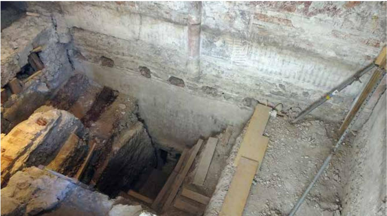
Abb. 6: Tiefensondage während der zweiten Grabungskampagne, links abgebrochene Ostmauer mit div. Störungen, oben Wandfresken und -säulen der Südmauer, darunter anschließend spätromantisches Mauerwerk mit Deckenbalkenlöchern, die abgescherten Balken auf tieferem Niveau erhalten (links unterhalb), eine weitere Balkendecke an der tiefsten Stelle zu erkennen, die Untergeschoße vollflächig verputzt, links Altarstelle (Basisplatte).
