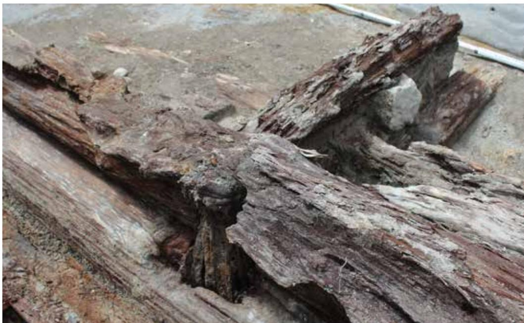
Abb. 3: Münzergasse 2, Verkämmung von Längs- und Querhölzern der Uferbefestigung mit senkrecht durchstoßendem Holznagel.
