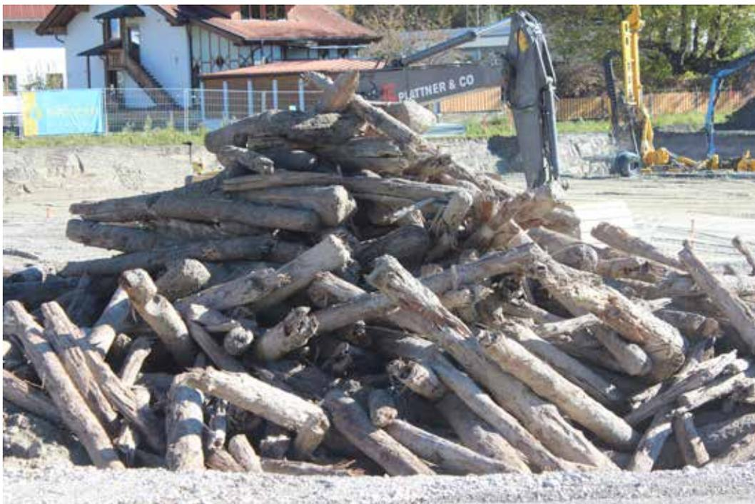
Abb. 8: Baustelle Geppertstraße, 2015, ausgebaggerte Hölzer einer Uferbefestigung, die Stämme zeigten sehr ähnliche Holzverbindungen wie jene von 2013 am Brockenweg 2.
