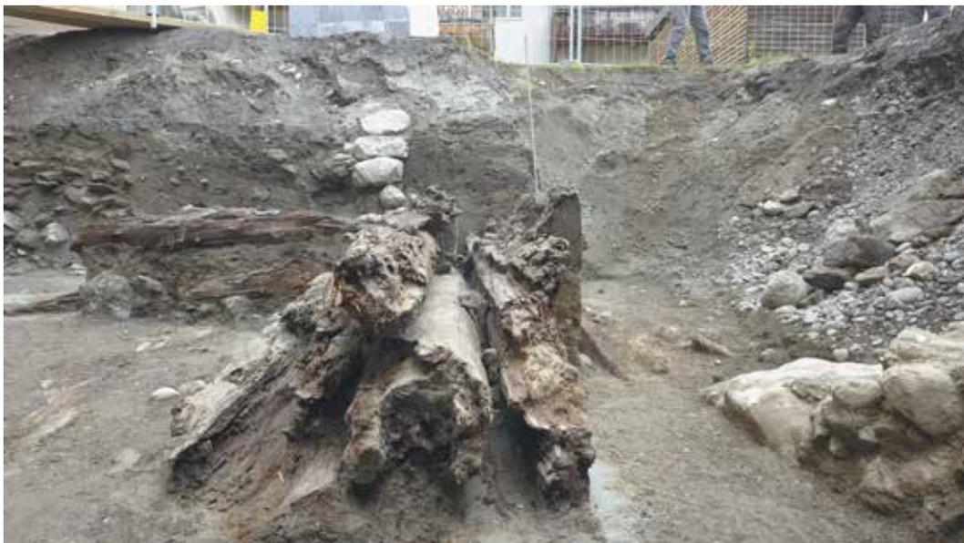
Abb. 2: Münzergasse 2, Querschnitt der freigelegten Teile der Uferbefestigung, Krainer-Wand, darüber eine mauerartige Steinsetzung; vorgelagert (rechts) eine Bohlenwand; unterhalb vermutlich ältere Konstruktionen in der Art, wie sie 2013 am Brockenweg beobachtet wurden; ganz rechts Teile der Basteimauer.
