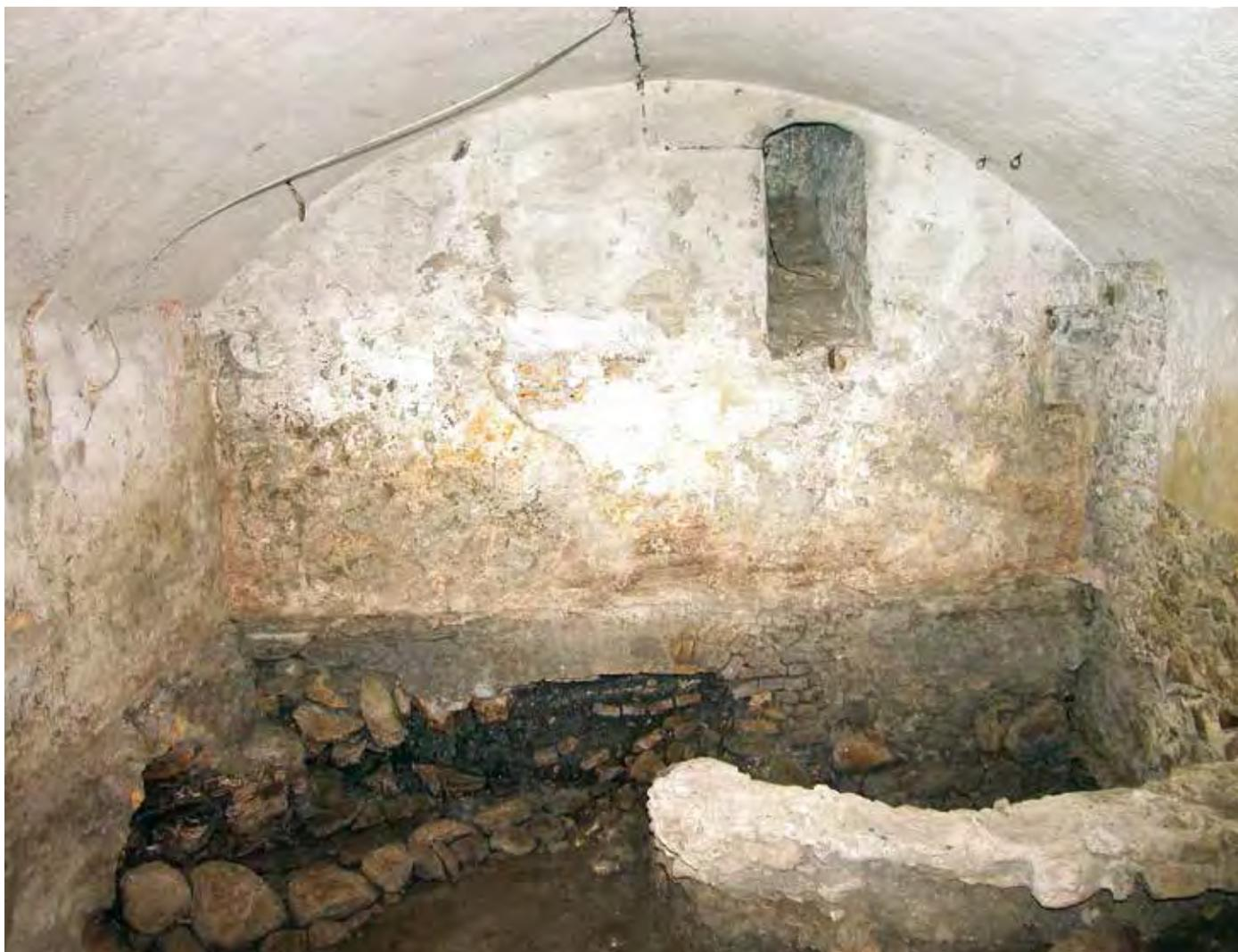
Abb. 5: Burg Hasegg. Ausgrabungen in Raum 1.17. Blick gegen die Stadtmauer nach Westen, rechts Mauer eines spätromanischen Gebäudes, rechts unten Latrinengrube 1 aus der 2. Hälfte des 15. Jahrhunderts, oben und links Erweiterung und Einwölbung um 1500, links unten schräg durch den Raum verlaufender Kanal etwa des 18. Jahrhunderts. Foto: A. Graf.
