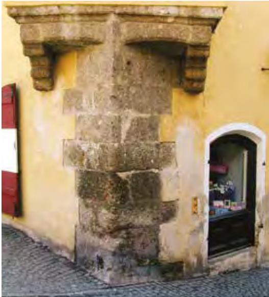
Abb. 3: Langer Graben 8 (NW-Ecke). Eckbetonung mit Erkerfuß (spätgotisch?). Verfärbung im unteren Bereich einer Mauerkante, bedingt durch Verschmutzung. Die Verschmutzungen, Verfärbungen und Schäden sind im Bereich der aufsteigenden Bodenfeuchte besonders intensiv.
