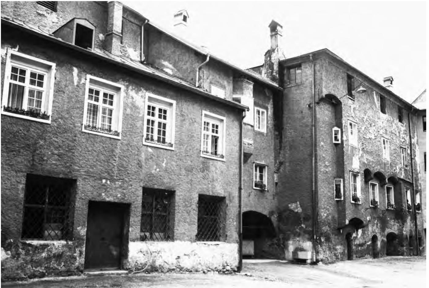
Abb. 3: Burg Hasegg 1979. Zustand vor der Renovierung. Links „Alte Münze“, rechts Nordwesttrakt mit den zum Teil erkennbaren Blendarkaden der spätgotischen Neugestaltung, die die dahinter sich befindlichen Baukörper unter einer einheitlichen Fassade zusammenfasst. Foto: BDA Tirol K 14.109.
