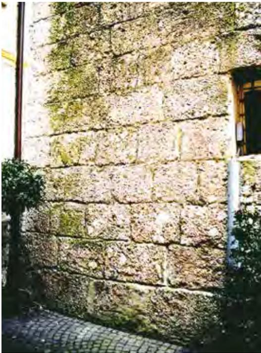
Abb. 4: Mustergasse 1 (Nordostseite). Erdbeben-Strebepfeiler (barock). Verfärbung eines Mauerabschnittes bedingt durch den Bewuchs von Algen und Moosen. Hier zeigt sich, dass neben dem Bewuchs der Quaderoberflächen vor allem der Mörtel in den Fugen stärker als die Quader verwittert ist und insgesamt einen höheren Materialverlust aufweist.
