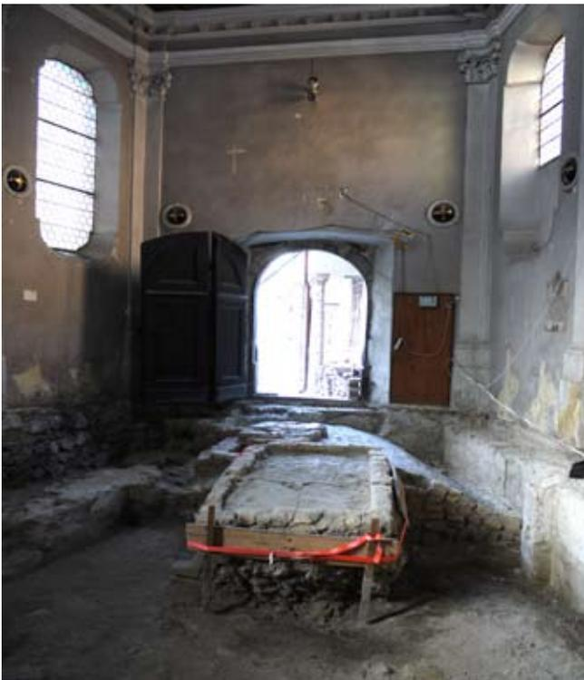
Abb. 35: Josefskirchlein gegen Westen, links und rechts bzw. unter der heutigen Westmauer die erhaltenen Mauern der Wolfgangskapelle, links unter dem geöffneten Türflügel eine weitere, gotische Eingangssituation, mittig Treppenabgang zur barocken Gruft dahinter (Tonnengewölbe).
