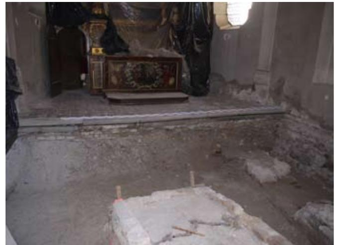
Abb. 34: Josefskirchlein, bis ca. 1 m starke Auffüllungen mit Bauschutt unter dem modernen Fußboden, woraus sich die Bodenabsenkungen erklären; im Vordergrund Abgang zur barocken Gruft.
