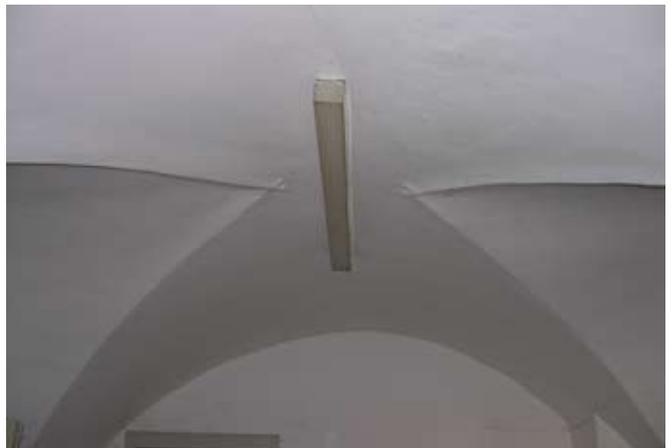
Abb. 13: Glashüttenweg 15, Putzgratgewölbe in einem der erdgeschoßigen Räume.
