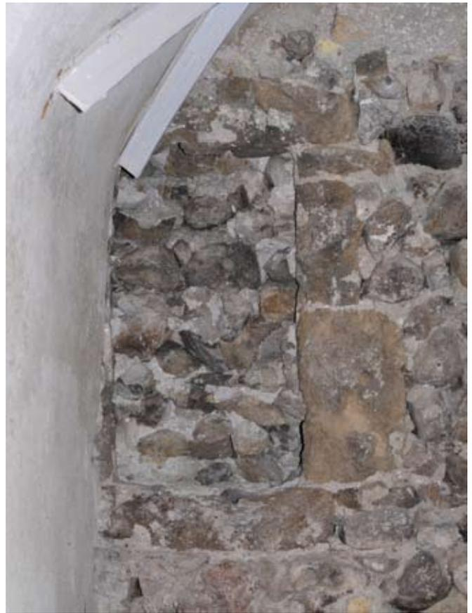
Abb. 2: Haus Arbesgasse 13, spätromantisches Fenster mit Tuffsteingewände in der Südmauer, im Zuge der gotischen Einwölbung zugesetzt, links gotischer Treppenaufgang Untersicht.
