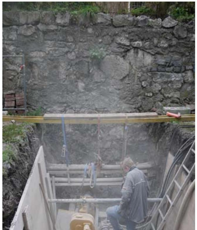
Abb. 24: Stadtgraben/Schumacherweg, September 2009; die Grabenstützmauer wird in einer Tiefe von ca. 1,8 m unter Geländeniveau durchbohrt.
