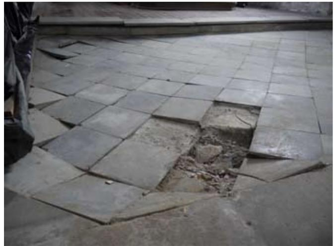
Abb. 33: Josefskirchlein, stark abgesunkene Teile des Bodenbelags.
