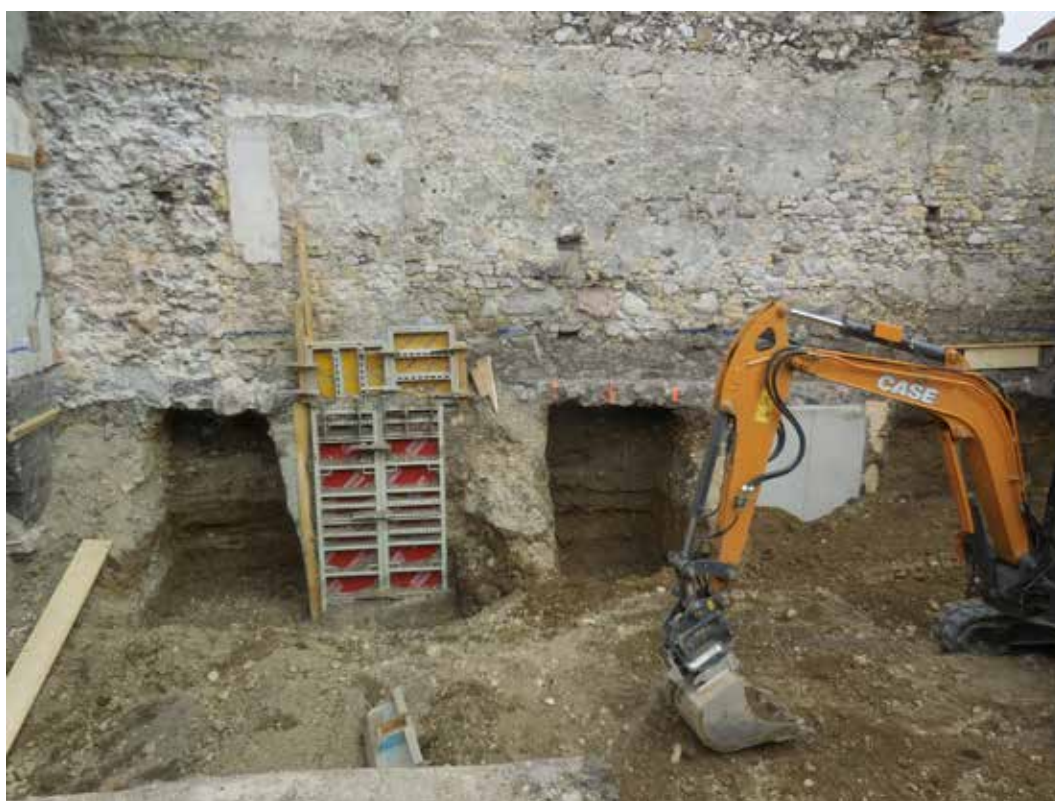
Abb. 1: Unterfangung der Friedhofs- mauer an der Adresse Waldaufstraße 20.
