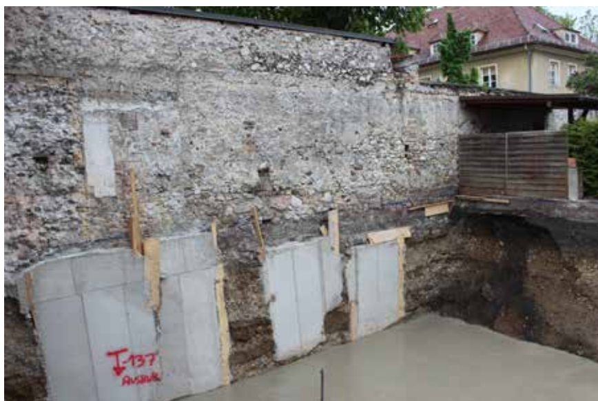
Abb. 3: Waldaufstraße 20, nach der Freigabe der Baustelle.
