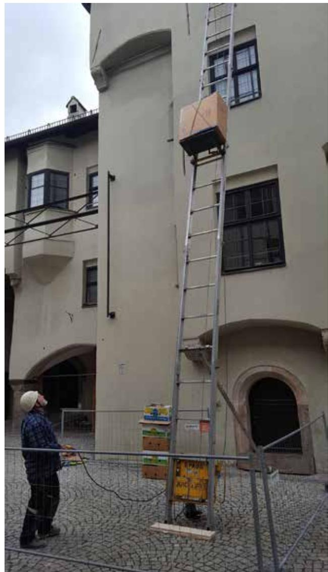
Abb. 9: Arbeitserleichterung dank des Bauliftes der Firma Anker Dach & Glas.
