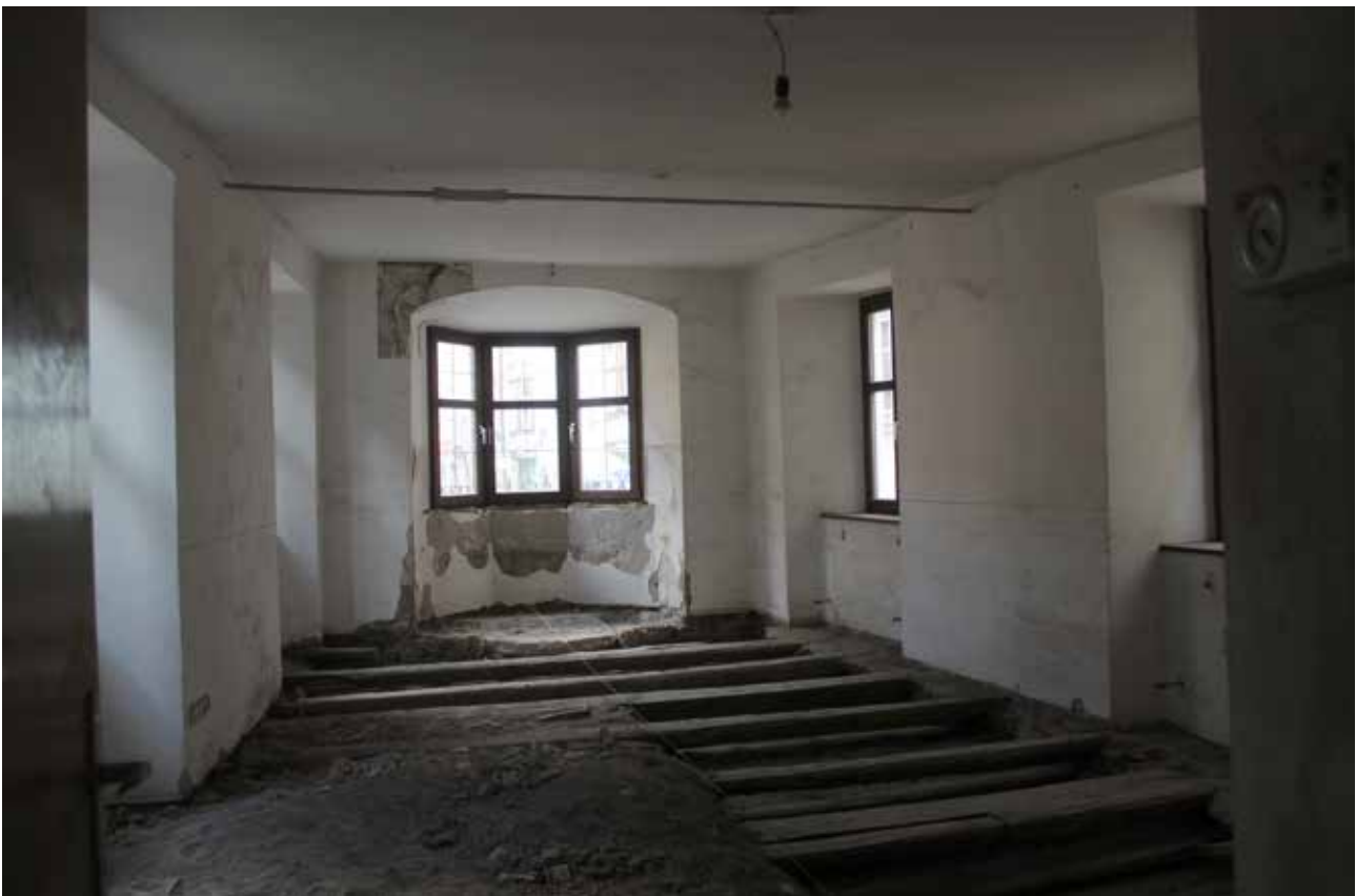
Abb. 7: Haus Wallpachgasse 3, OG 1, Blickrichtung Nord, eine Zwischenwand wie in den Geschoßen darüber nicht mehr zu erkennen, stattdessen eine Eisenschleuder durch den Raum, im Hintergrund Polygonerker. Foto: A. Zanesco.
