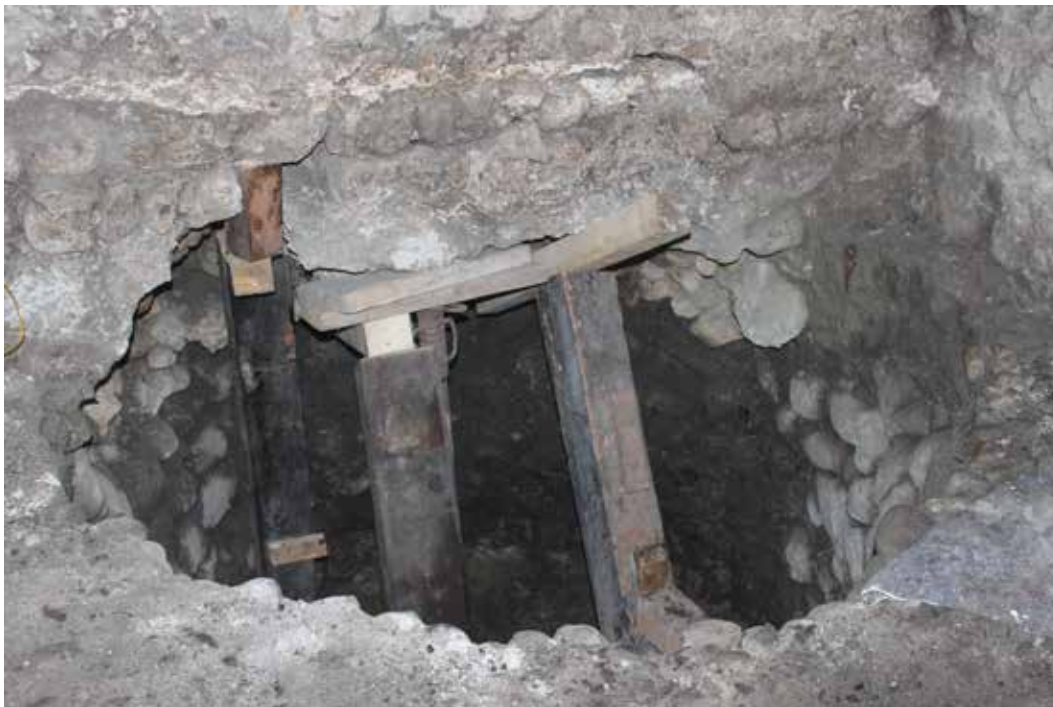
Abb. 4: Hall in Tirol, Schmiedgasse 22, westlicher Raum im Erdgeschoß, Nordwestecke, Blickrichtung Nordwest, links Westmauer, die (hinten) an die Nordmauer läuft (Südmauer des Hauses Salvatorgasse 19), darunter rund gemauerte Latrinengrube nach Entfernung des Inhalts, dazu statische Sicherungen. Foto: A. Zanesco.
