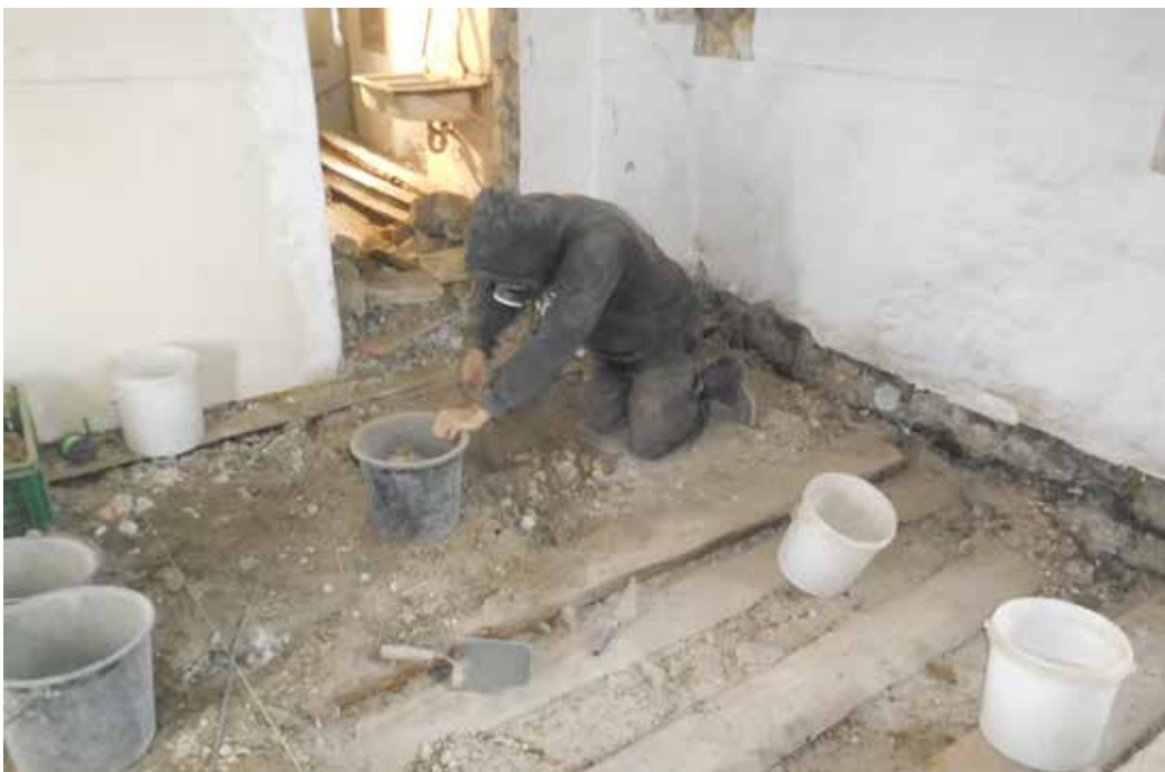
Abb. 6: Haus Wallpachgasse 3, OG 3; das Durchsuchen der Schüttungen ist nur mit Atemschutz möglich. Foto: S. Heim
