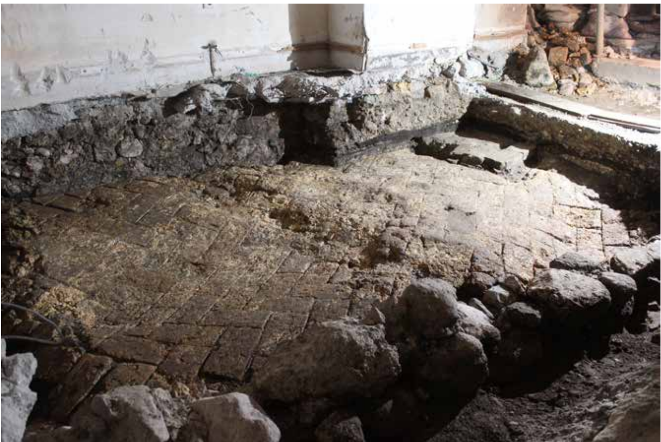
Abb. 5: Hall in Tirol, Schmiedgasse 22, nordöstlicher Raum im Erdgeschoß, östliche Hälfte, Blickrichtung Südost, stark verformter Ziegelboden im Streiflicht, im Vordergrund Trennmauer, rechts hinten Mauersockel, darüber der heutige Rauchabzug, hinter diesem Überreste vermutlich einer Schmiedeesse. Foto: A. Zanesco.
