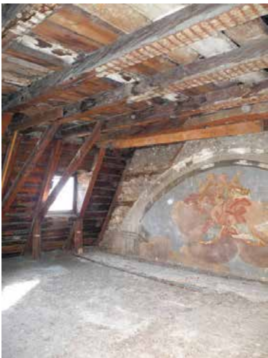
Abb. 14: Freskenreste mit Engelsdarstellungen am Dachboden des Nordosttraktes des ehemaligen Jesuitengymnasiums, heute Volksschule am Stiftsplatz.
