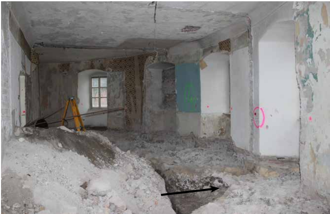
Abb. 6: Unterer Stadtplatz 19, 2015. Knapp 3 m starke Außenmauer der Bastion aus dem 15. Jahrhundert, oberhalb der Abbruchfläche von innen ausgehöhlt, Schartennische rechts unten (Pfeil).
