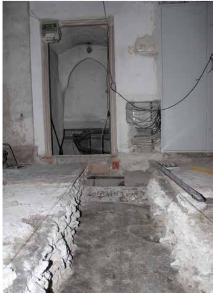
Abb. 9: Stadtpfarrkirche St. Nikolaus. Erdgeschoß des Turms, Abtiefung auf romanischen Mörtelstrich, darüber Auffüllungen mit Bauschutt, oberer Abschluss durch Ziegelplatten-/Marmorplattenboden im Sandbett, moderner Bodenaufbau bereits entfernt, im Hintergrund Abgang in das Untergeschoß der Sakristei nach links, verschneidet sich mit einer zugemauerten frühgotischen Türöffnung, die ihrerseits sekundär eingebaut wurde, letztere führt in das Presbyterium bzw. zum ehemaligen Treppenraum.
