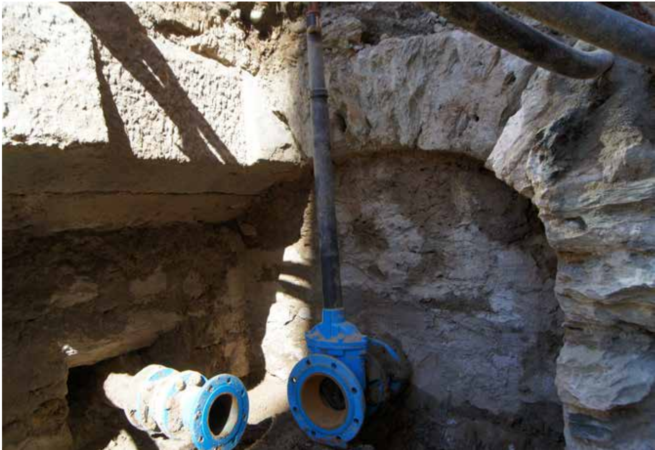
Abb. 6: Langer Graben 2014. Am unteren Ende des Langer Grabens, gewölbter Revisionsschacht vermutlich Ende 19./frühes 20. Jahrhundert in neuerlicher Verwendung.
