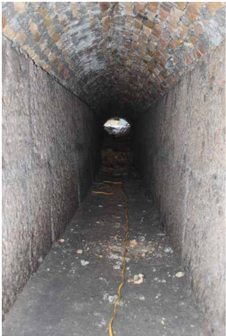
Abb. 7: Friedhof St. Nikolaus 2014. Tunnel entlang der Ostseite der Kirche, Blickrichtung Süd.
