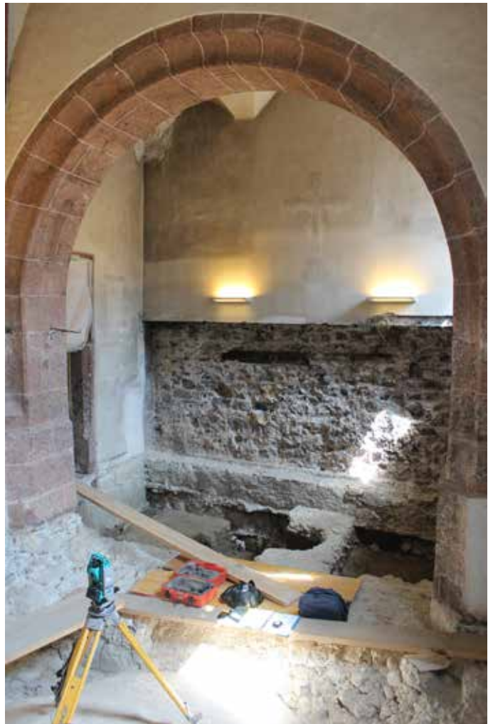
Abb. 10: Stadtpfarrkirche St. Nikolaus. Erdgeschoß der Sakristei, Blickrichtung Nord, im Vordergrund freigelegtes Gewölbe, hinter dem Bogen ehemaliges Friedhofsareal, das überbaut wurde, hinten links Zugang zum Turm.
