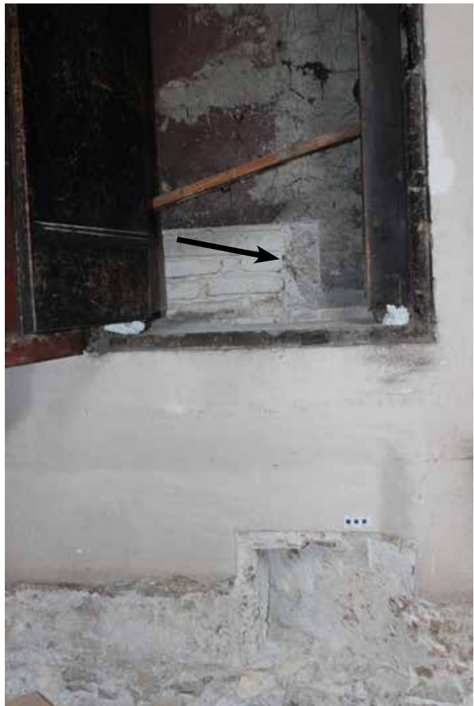
Abb. 11: Stadtpfarrkirche St. Nikolaus. Erdgeschoß der Sakristei, Südwestecke, Blickrichtung West, unten erkennbar der ehemalige Zugang zum dahinter liegenden Treppenturm, hinter der die Stellen nun einnehmenden Wandnische die Südostecke des Kirchturms freigelegt (Pfeil).
