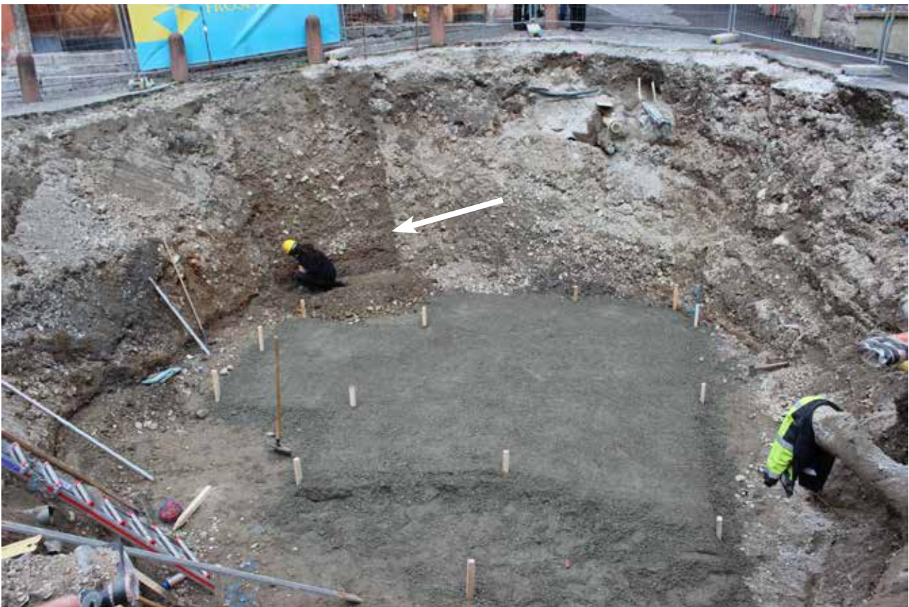
Abb. 1: Am „Unteren Platz“ 2014. Baugrube zum Tosbecken der Kanalisation, Blickrichtung Nord, links unten veriegelte Flussandschichten und Kohleschichten einer Uferzone knapp drei Meter unter der heutigen Oberfläche (Pfeil).
