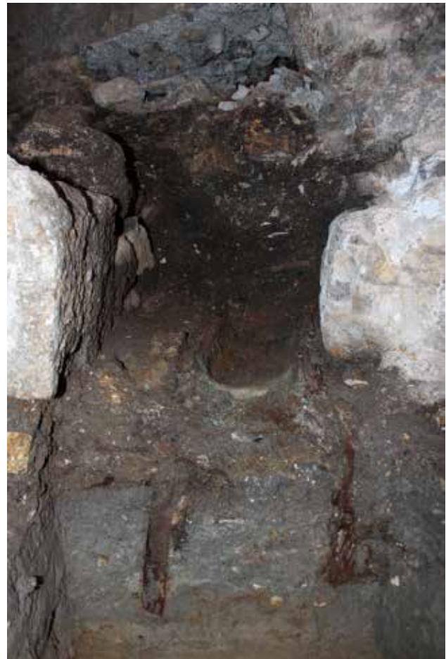
Abb. 2: Burg Hasegg, Raum 1.16. Kanal, Blickrichtung Nordwest. Das Fundamentmauerwerk (rechts) spart diese Trasse bereits aus und wird später noch aufgeweitet; darin eingelegt eine Holzhalbröhre, seitlich fixiert mit Holzstangen, die Rinnenabschnitte verbunden durch Kupfersteckmuffen; links aufsitzend eine jüngere Mauer als Substruktion der Kellermauer (vgl. Abb. 1).
