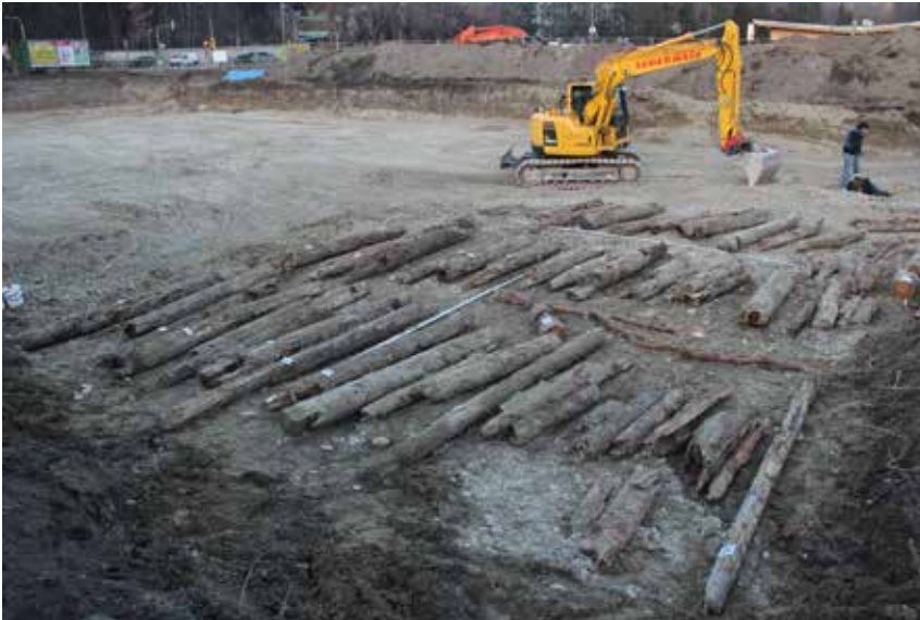
Abb. 3: Brockenweg 2. Aufgelegte Rundhölzer, die im Zuge der Erdbelegungsarbeiten ausgebaggert wurden.
