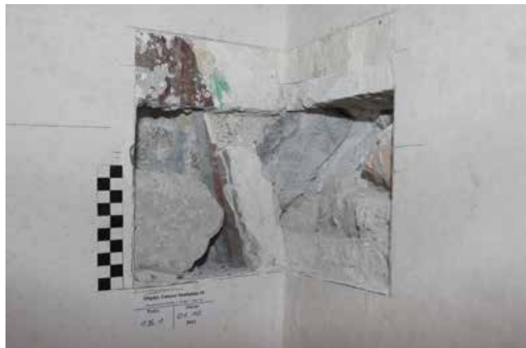
Abb. 8: Unterer Stadtplatz 19. Raum 1.16, NW-Ecke, sekundär eingebaute Wandnische mit bogigem Abschluss.
