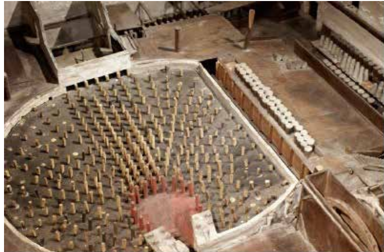
1774 1:50 Modell einer Saline in Hall mit der Unterkonstruktion der 280 m 2 großen Pfanne.
