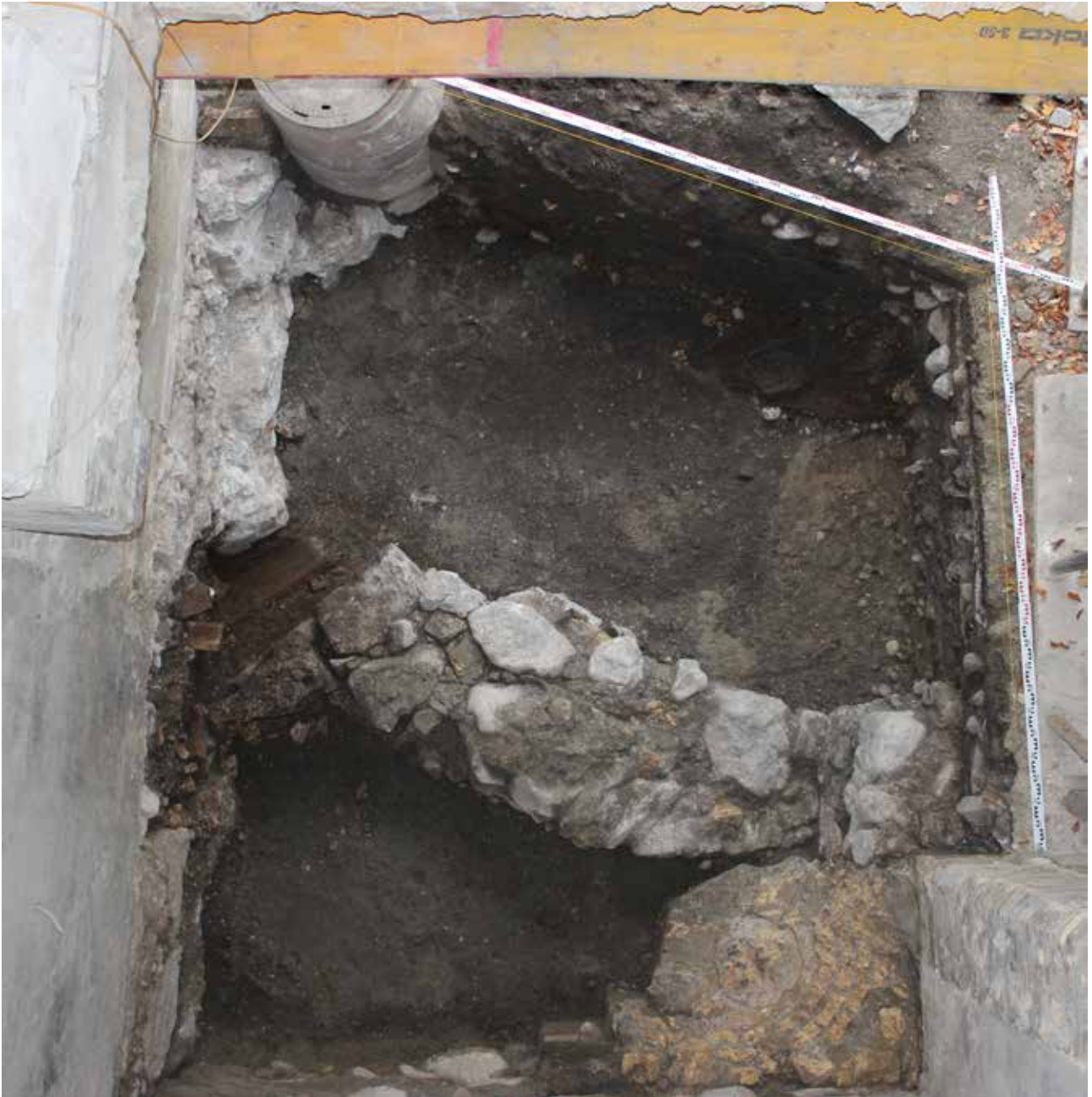
Hall i. T./Burg Hasegg 2012. Baugrube zum Liftschacht, links Kanal durch die Fundamentmauer des Westtrakts, mittig Grundmauer zum abgebrochenen Keller, rechts unten am Fundament des Arkadenpfeilers eine ziegelgemauerte Struktur mit glockenförmiger Mulde.
