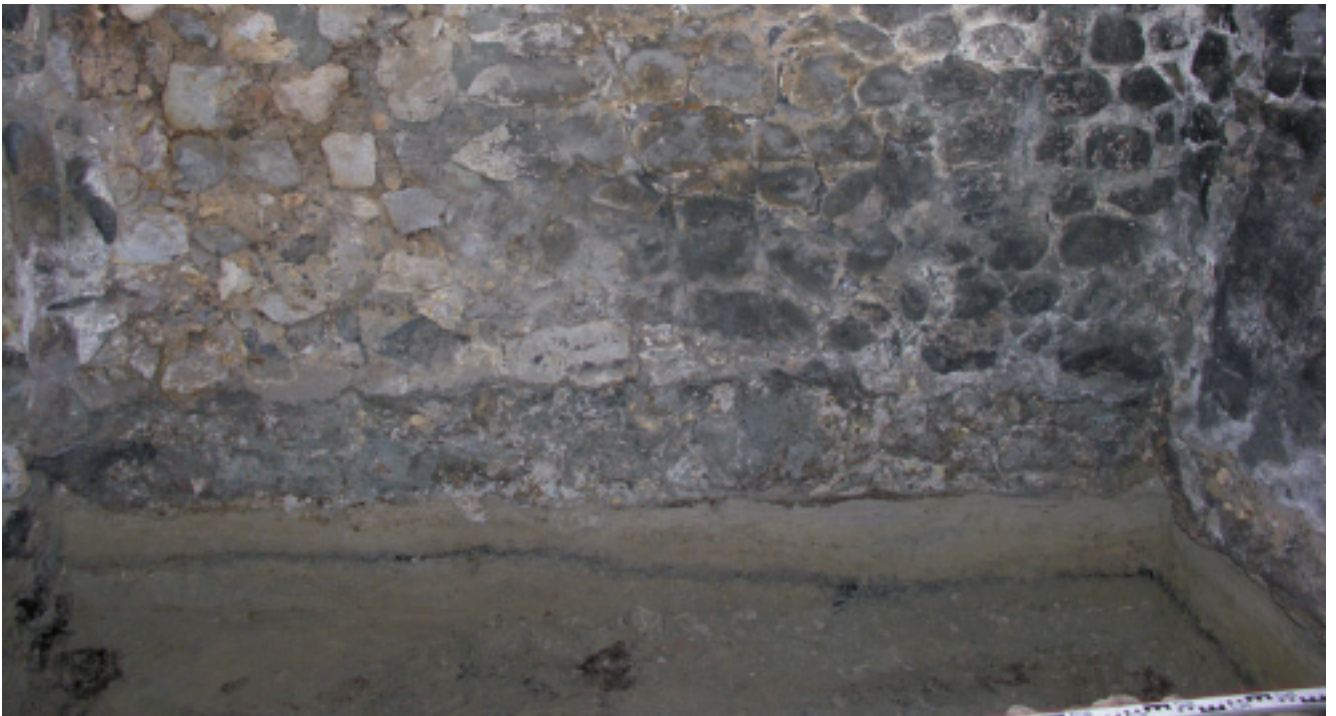
Abb. 4: Grabung Schlossergasse 1. Ähnliche Situation wie oben, deutlich zu erkennen, das in die natürlichen Bodenschichten eingelagerte dünne Holzkohlenband, welches zum besseren Verständnis der Entwicklung des Haller Schwemmkegels datiert werden könnte.
